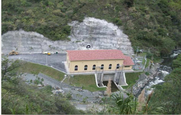
Foto 4: Casa de máquinas Central Amaime
