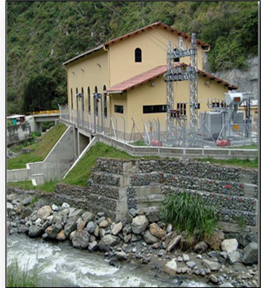
Foto 1: Casa de máquinas Central Amaime
