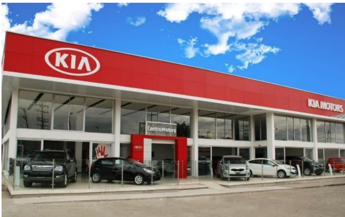
Ilustración 17. Fachada Centro Motors S.A 2018 Fuente: Gestión Documental Centro Motors.
