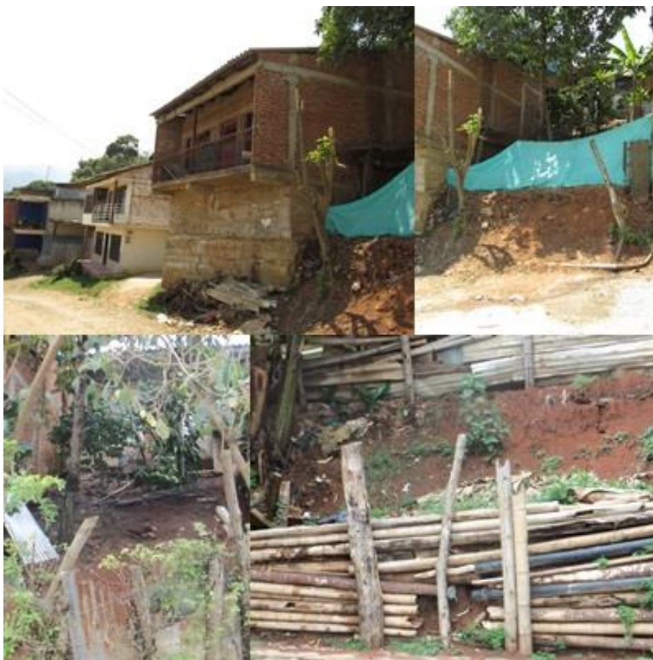
Figura 29. Deslizamientos en el barrio Villa María al sector 1
