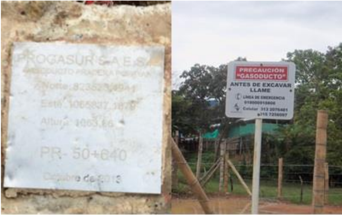
Figura 69. Señalización del paso del gasoducto Fuente: Ceidy Castillo y Nisley Zúñiga
