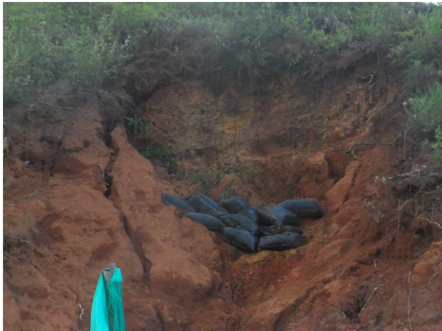
Figura 62. Costales de tierra puestos por los habitantes para detener el deslizamiento. Fuente: Elaboración propia
