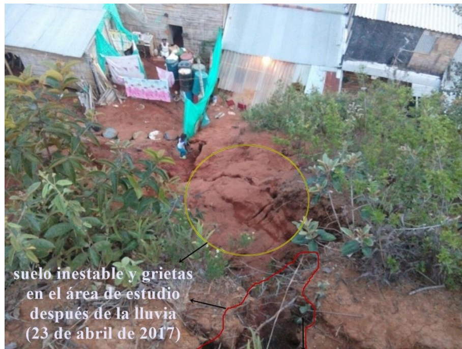
Figura 61. Estado de la ladera después del deslizamiento Fuente: Elaboración propia
