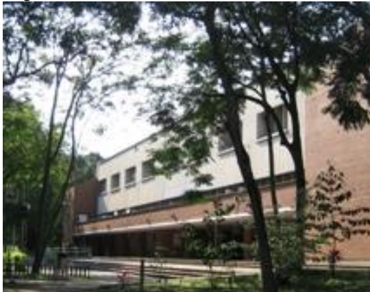
Figura 4-1: Edificio de Administración Central
