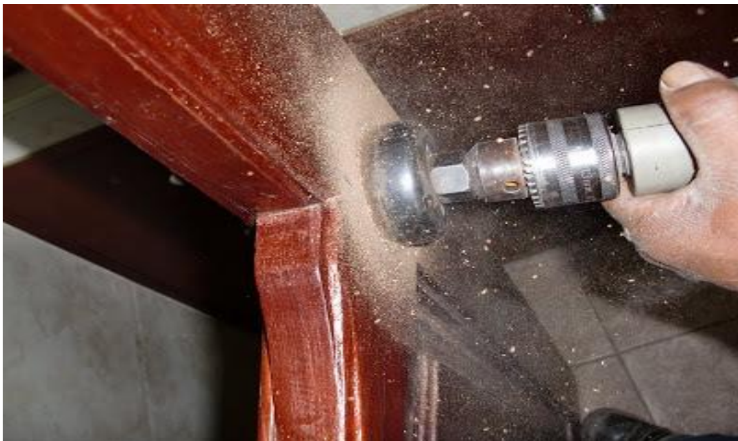
Figura 7. máquina para perforar sobre madera para incorporar chapas.
