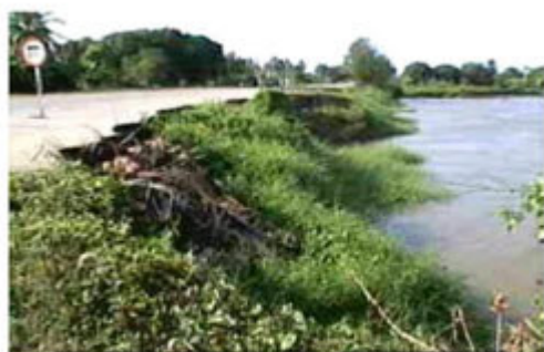
Figura 1. Vista general de la situación de la carretera Lorica-San Bernardo del Viento, afectada por la erosión de la margen izquierda del río Sinú, al momento del diseño.
