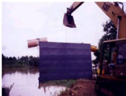
Figura 5. Paneles fabricados listos para su instalación y transporte al sitio.
