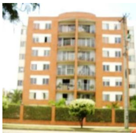
Figura 13. Edificio Torres de Santorino Torre B.
