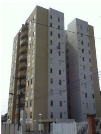
Figura 10. Edificio Pio XII Torre de Apartamentos.
