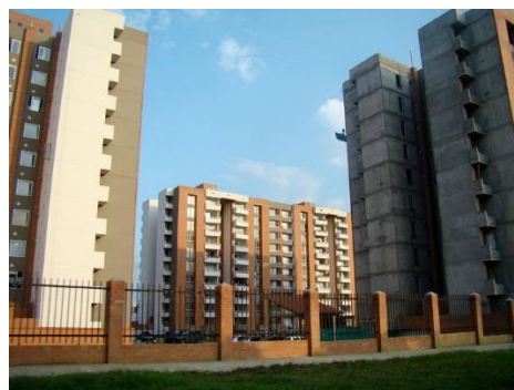
Figura 11. Edificio Portal del Lili.
