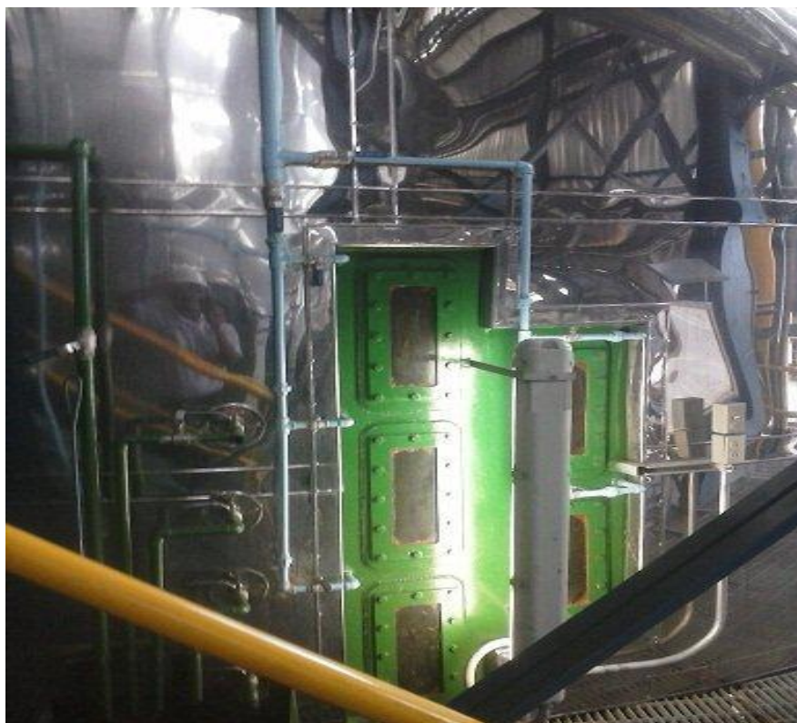
Figura No. 5. Tanque de clarificación del jugo.
