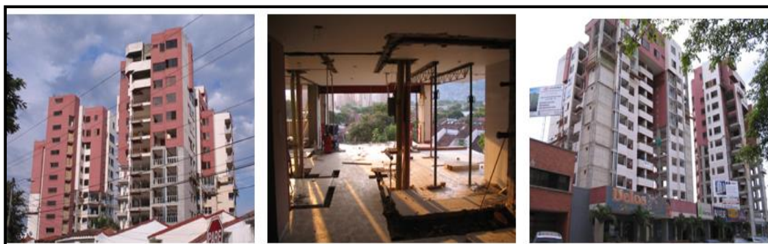
Figura 4 Reforzamiento estructural pantalla concreto Torres de Alicante
