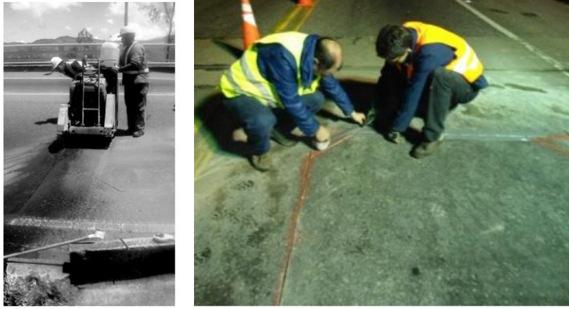
Figura 4. Instalación de sensores en la superficie del pavimento [33].
