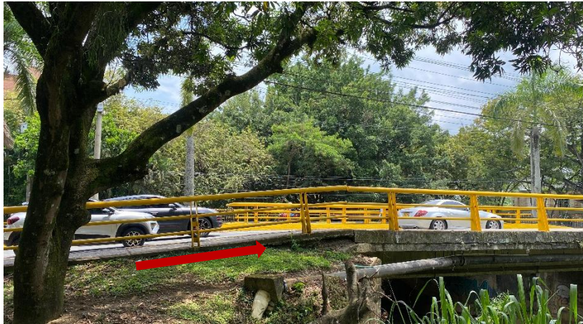
(a) Vista general del puente.
