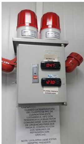
Fotografía 2. Medidor de temperatura cuartos fríos. Hemocentro Banco de Sangre Hospital Universitario del Valle Evaristo García. 2017
