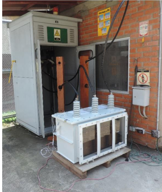
Figura 10. Montaje prueba sobre el transformador de 75kVA.
