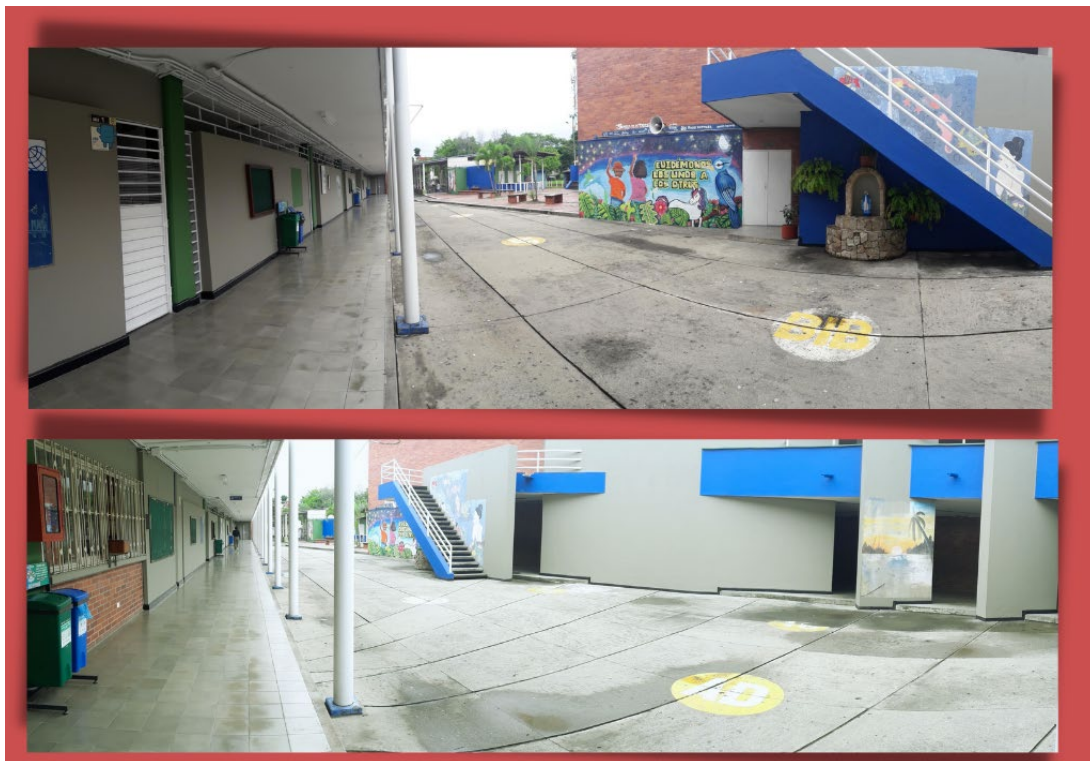
Figura 5. Instalaciones de IETI Comuna 17.
