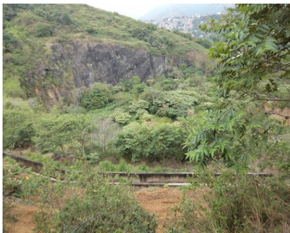
Figura 14. Canalización quebrada San Antonio.
