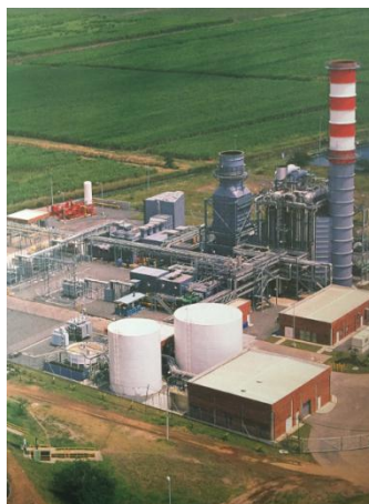
FOTO13. Planta Termovalle (Cortesía de EPSA)
