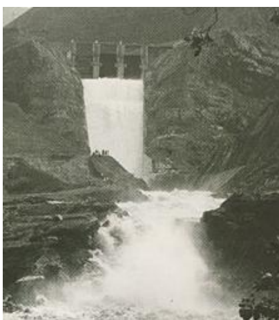
FOTO 3. Represa Alto Anchicayá. (Cortesía de EPSA)
