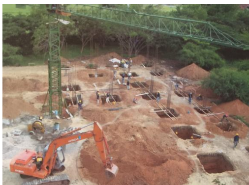
FOTO20, Construcción Edificio EPSA (Cortesía de EPSA)
