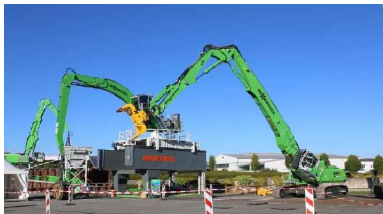
Figura 9: Maquinaria Sennebogen en funcionamiento
