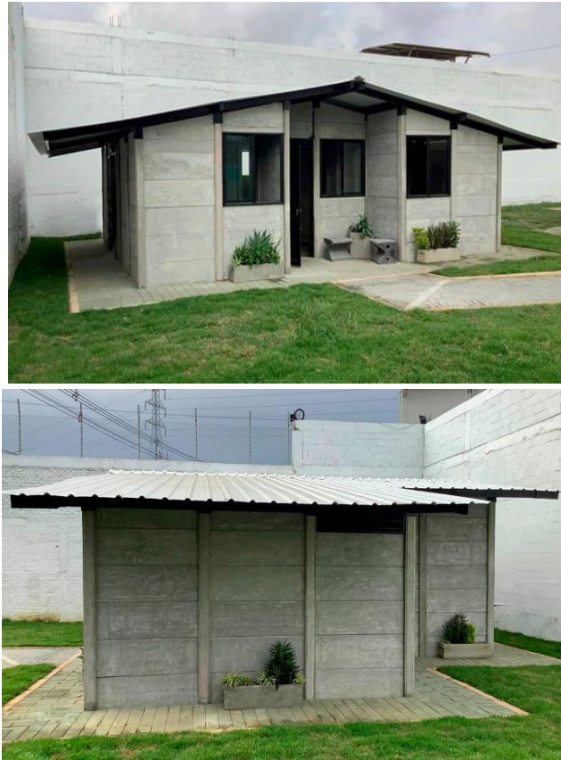
Figura 25. “Proyecto Vivir” Casa piloto sistema de construcción con elementos prefabricados 100% desmontables. Fuente. PREMOLDEADOS SAS, 2025
