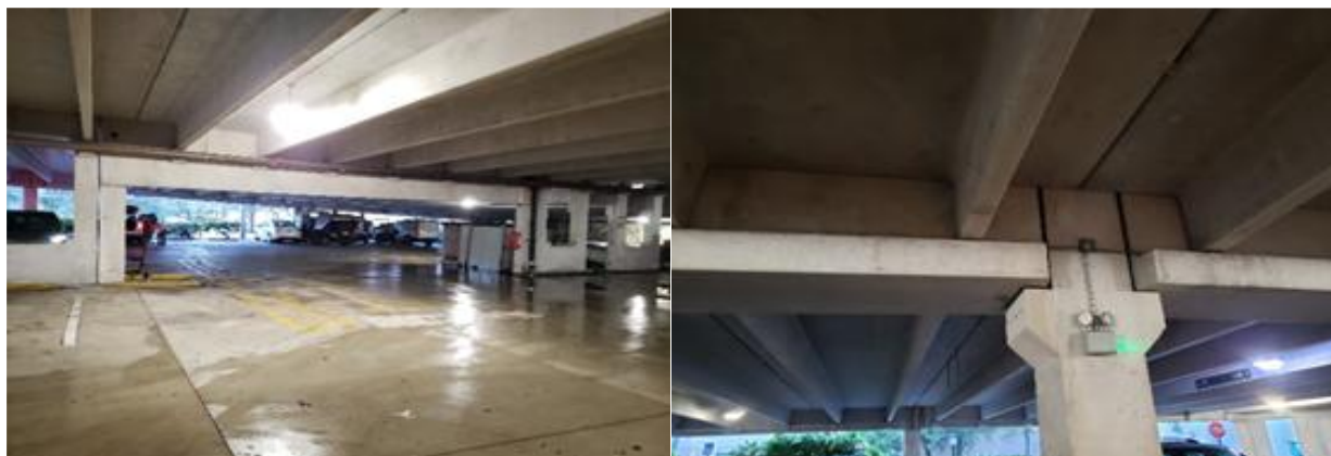
Figura 7. Elementos de construcción prefabricados en edificio de parqueaderos (Sawgrass Mills, Sunrise, Florida, Estados Unidos). Fuente: Elaboración propia.
