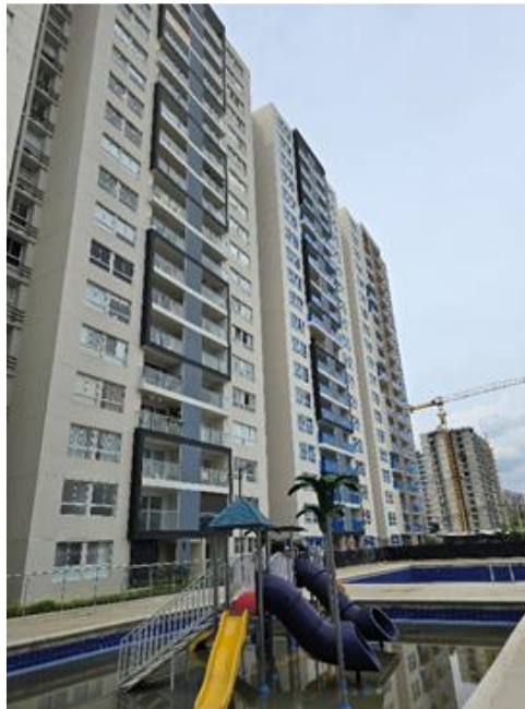
Figura 35. Edificio para vivienda, construido con concreto monolítico. Fuente: Elaboración propia.
