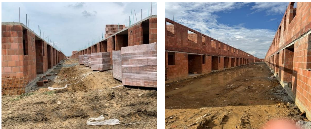
Figura 10. Vivienda de Interés social construcción mixta con elementos prefabricados y componentes vaciados en sitio Valle del Cauca (Colombia). Fuente: Elaboración propia
