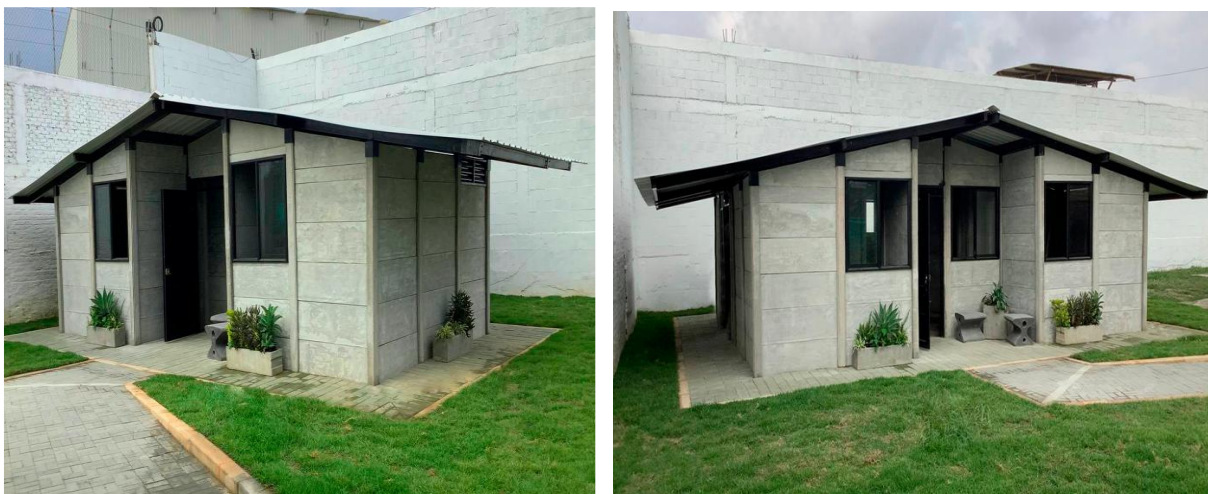
Figura 42. “Proyecto Vivir” Casa piloto sistema de construcción con DfD y los principios de la EC. Fuente. PREMOLDEADOS SAS, 2025
