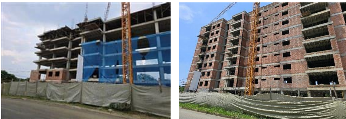
Figura 11. Edificio en construcción (Distrito Especial de Santiago de Cali, Ciudad Jardín) con tecnología aporticada y elementos de mampostería de ladrillo de arcilla cocida. Fuente: Elaboración propia.
