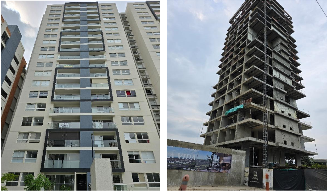
Figura 36. Edificio para vivienda, construido con concreto monolítico. Fuente: Elaboración propia.
