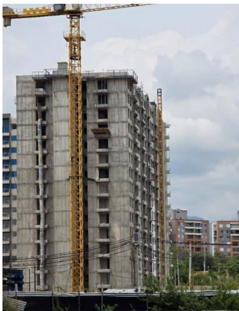
Figura 24. En primer plano edificio en construcción con tecnología de concreto monolítico; al fondo se aprecian otros, ya construidos con la misma tecnología. Fuente: Elaboración propia.
