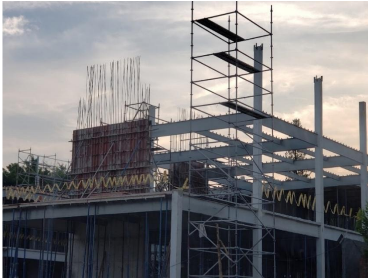
Figura 16. Estructura de una edificación en el sur del Distrito Especial de Santiago de Cali. Fuente: Elaboración propia
