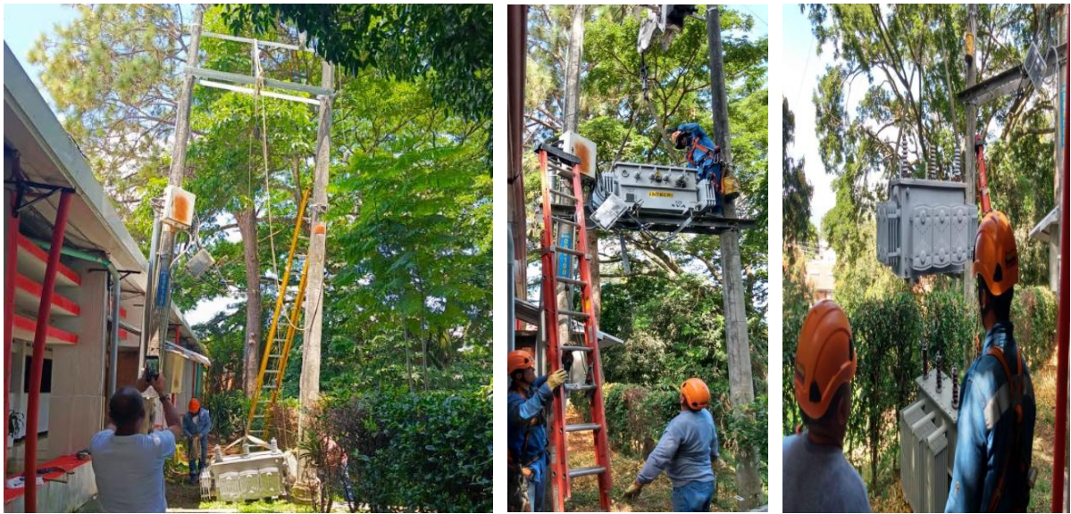
Figura 9. Mantenimiento sistema eléctrico.
