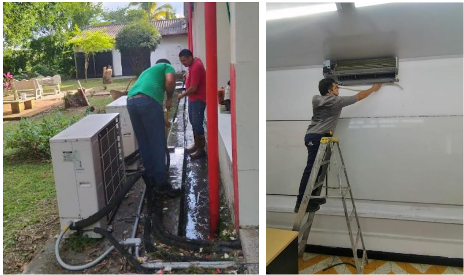
Figura 10. Mantenimiento sistema de climatización.
