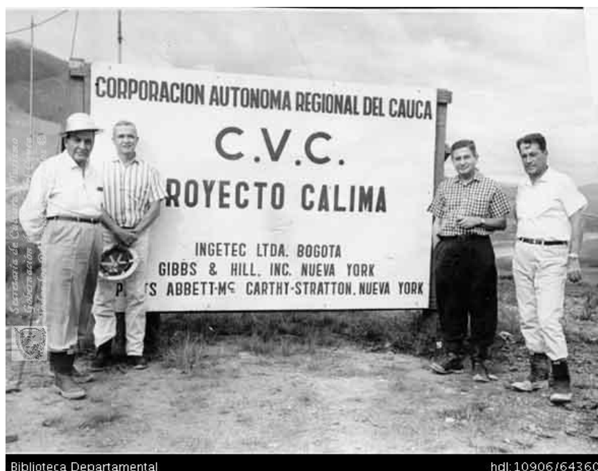
Ilustración 17. Foto Ingenieros a principios de 1962 pocos meses después de iniciar obras.
