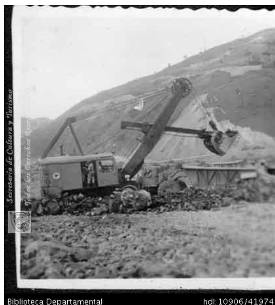
Ilustración 19. Construcción Lago Calima, Remoción de Tierras
