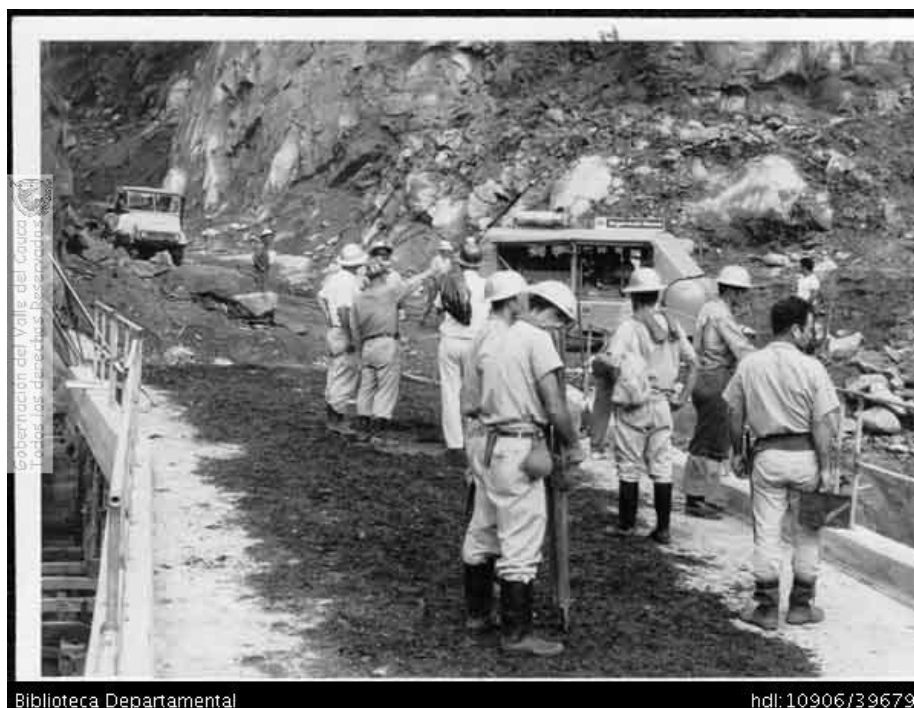
Ilustración 15. Obreros y maquinaria en la terminación del puente sobre el río Calima
