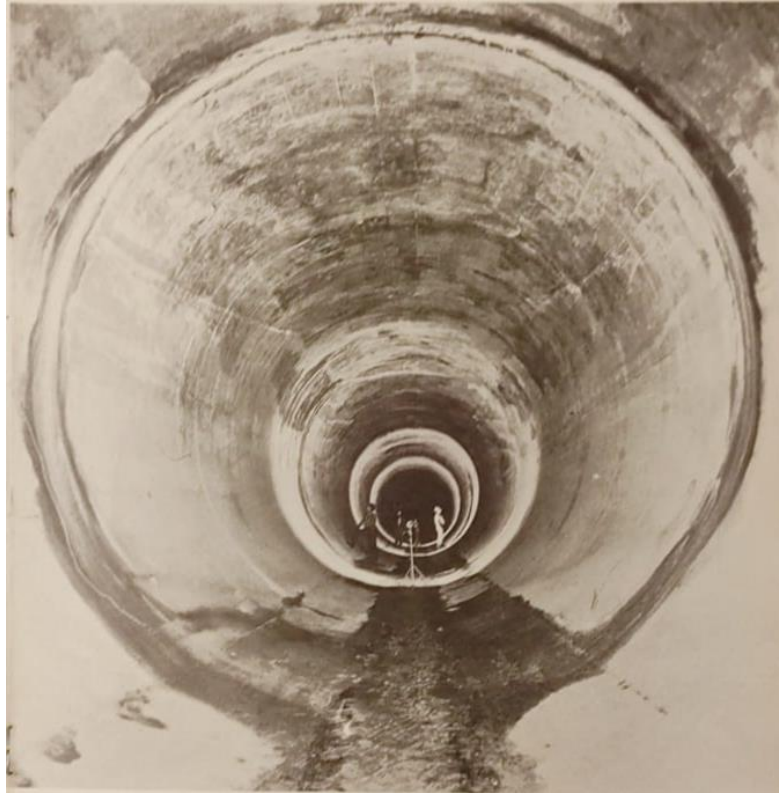
Ilustración 20. Túnel de Fuga de Calima en construcción
