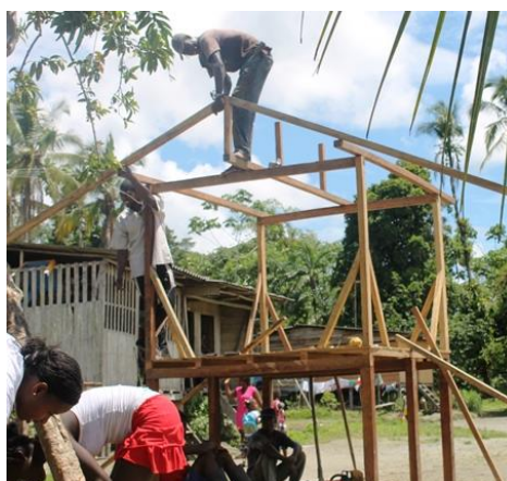
Figura 7: Construcción de parque. Fuente: https://fundescodes.org/sonando-pintando-parque-nuestra-vereda-armando/
