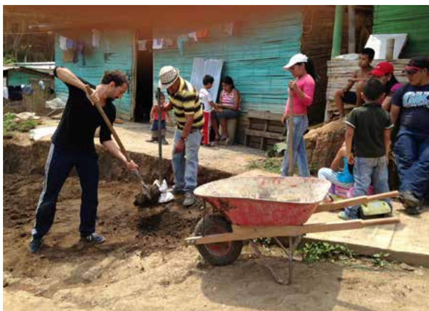
Aprendiendo a pavimentar en la minga del domingo Brisas de Alto Nápoles, Cali, 5 de febrero de 2015
