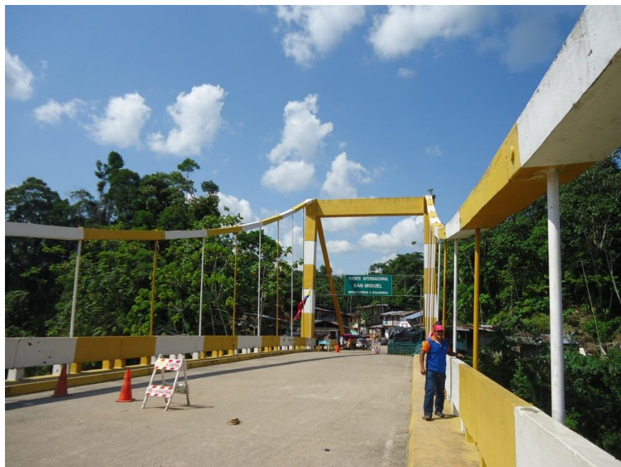
Fotografía No. 5: Frontera Colombia – Ecuador Puente Internacional San Miguel
