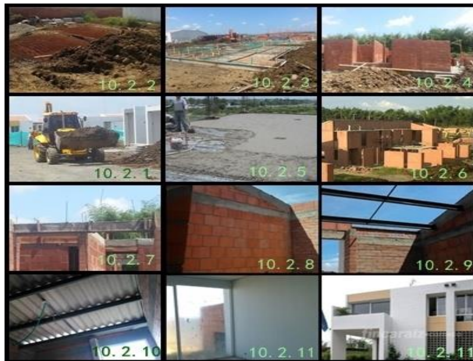
Figura 4. Fotografías de las etapas del proceso constructivo – Numeración de acuerdo con la descripción
