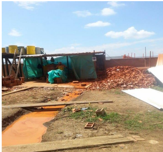
Figura 9. Sección de corte de ladrillo, campamento de construcción – Constructora El Castillo
