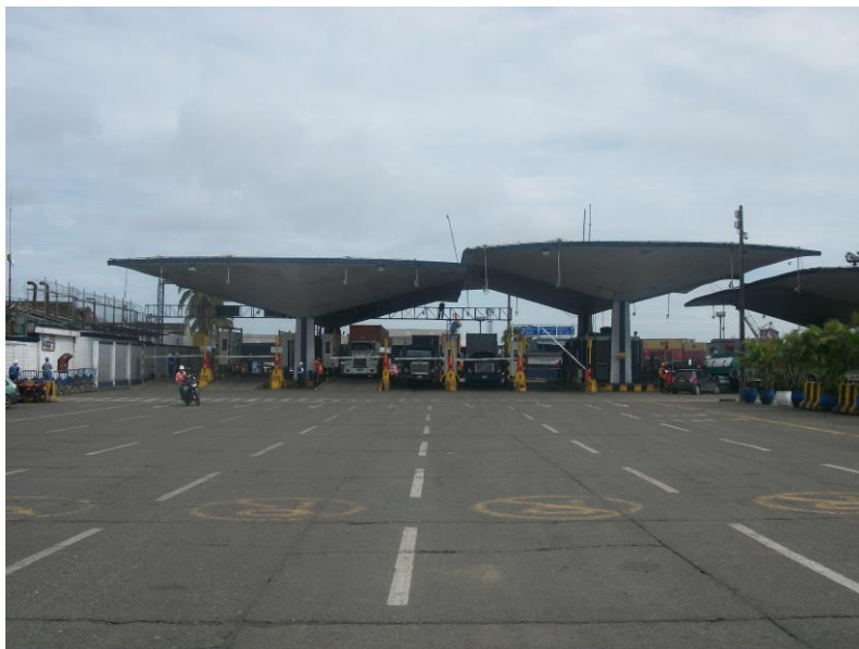
Anexo C. Fotografía Basculas Zona de Expansión Logística S. A. (ZELSA).
