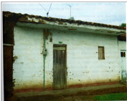
PRIMERAS VIVIENDAS CONSTRUIDAS EN BAHAREQUE
