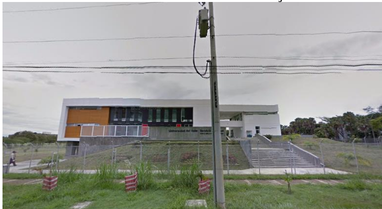
Ilustración 8. Edificio Emilio Aljure
