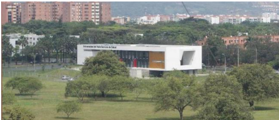
Ilustración 7. Edificio Emilio Aljure
