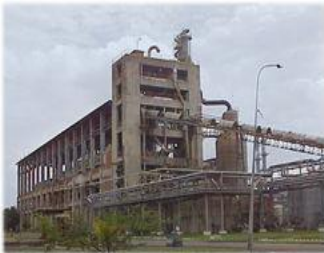
Figura 5. Planta de tratamiento de pulpa 12
