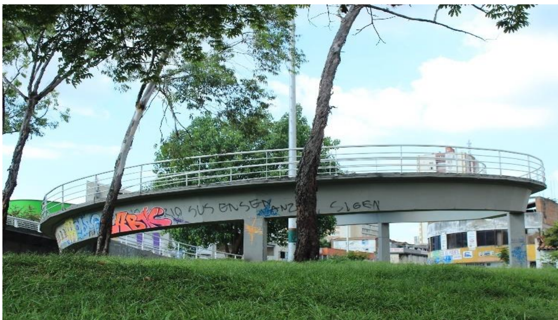
Imagen No. 20. Puente calle 5 con carrera 10
