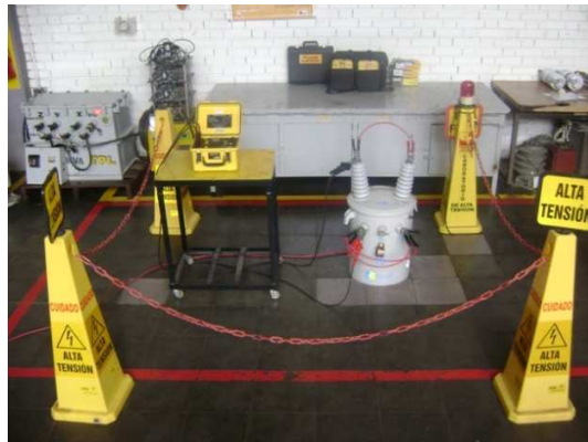
Figura 8. Montaje ensayo resistencia de aislamiento.
