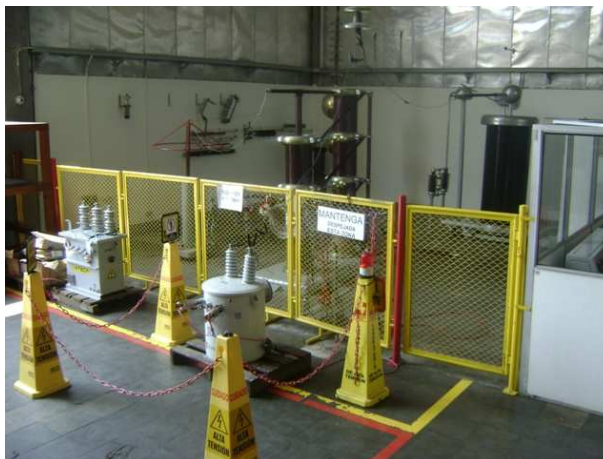
Figura 14. Montaje tensión aplicada en transformador.
