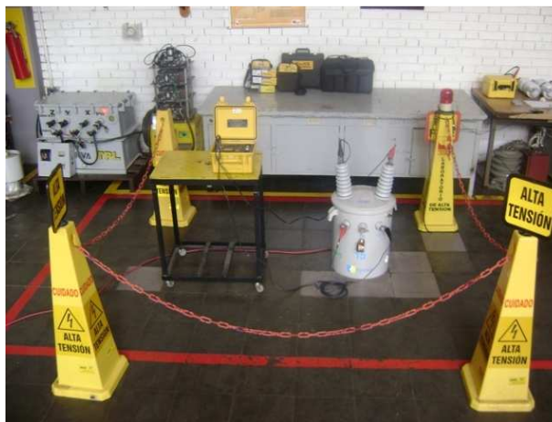
Figura 10. Montaje ensayo relación de transformación.
