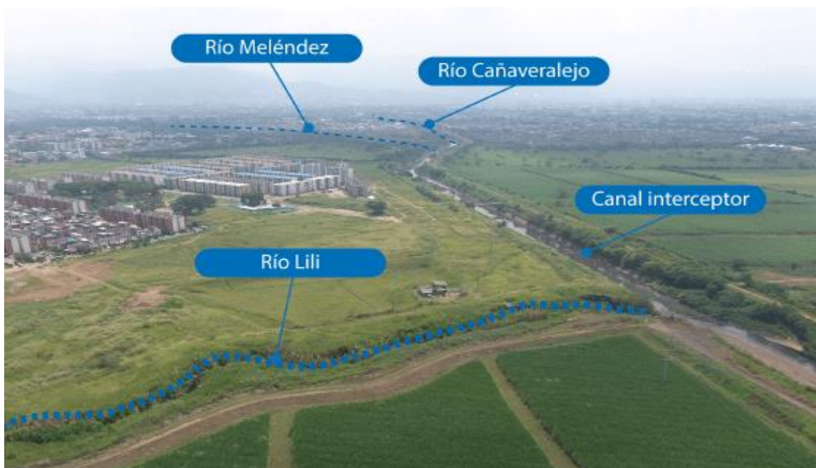
Imagen N°13. Visualización aérea de la convergencia del río Lili y el Canal Interceptor Sur CVC.
