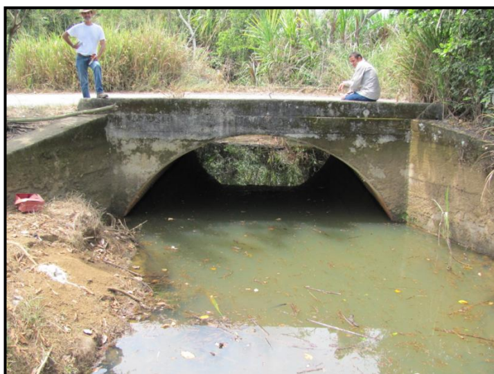
Fotografía 8.62. Alcantarilla de tubería
