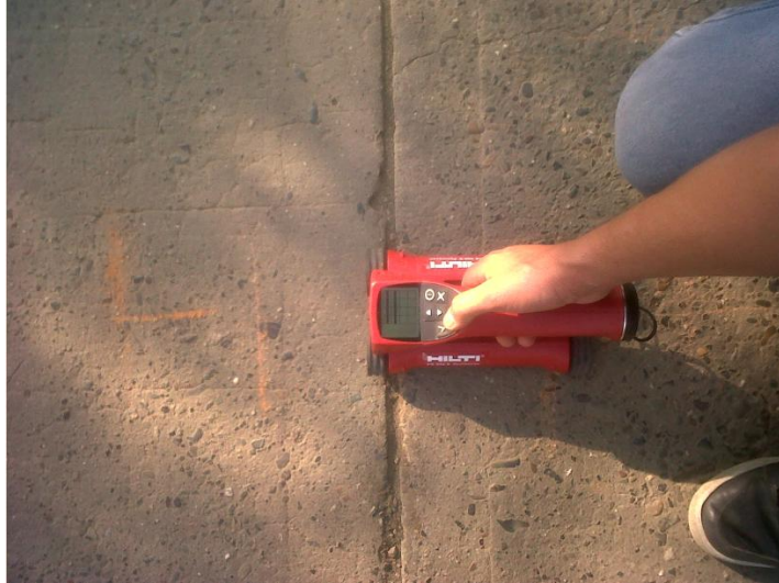
Fotografía 8. Detección de acero en la junta mediante equipo de detección magnética
