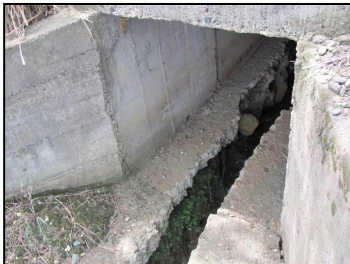
Fotografía 8.58. Alcantarilla en cajón
