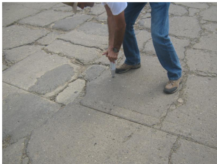
Fotografía 14. Prueba de esclerometría.
