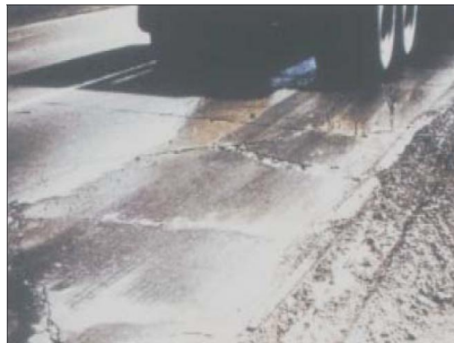
Fotografía 7. Vista típica de bombeo en juntas
