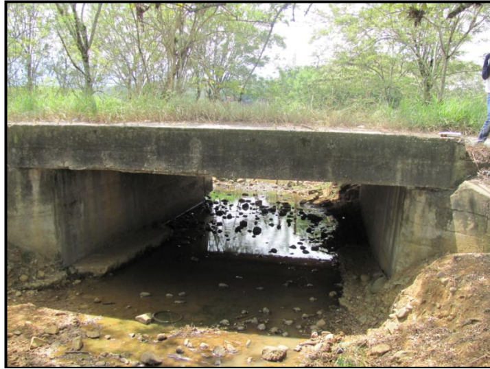
Fotografía 8.57. Alcantarilla en cajón
