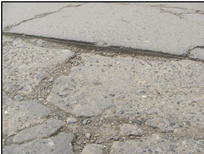
Fotografía 8.31. Escalonamiento de juntas longitudinales sector K2+000 a K2+245 (Ref. 6.2.5.14)
