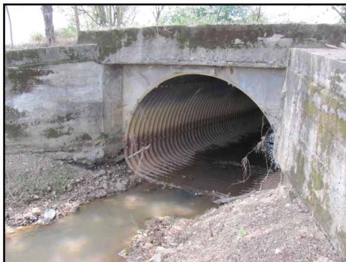
Fotografía 8.61. Alcantarilla de tubería
