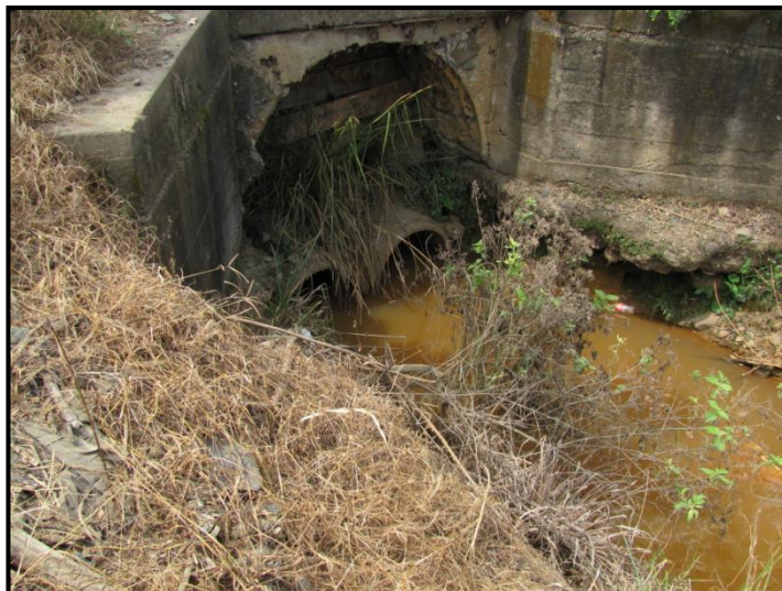
Fotografía 8.60. Alcantarilla con doble tubería
