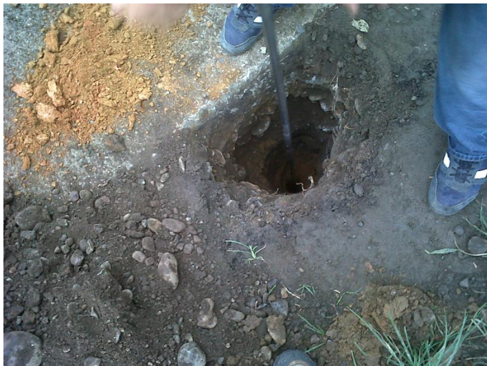
Fotografía 9. Realización de apiques
