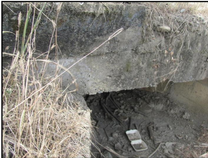
Fotografía 8.59. Alcantarilla en cajón
