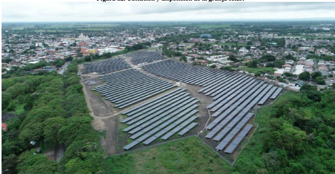
Figura 32. Ubicación y disposición de la granja solar.
