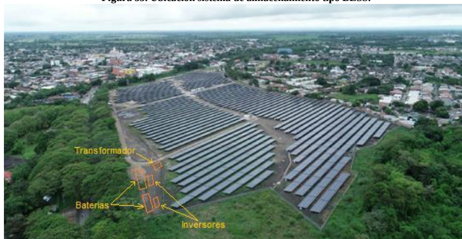
Figura 55. Ubicación sistema de almacenamiento tipo BESS.
