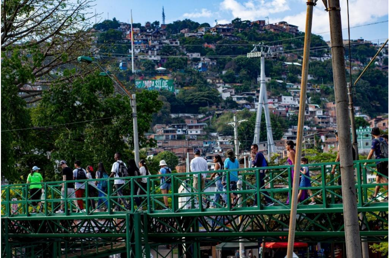
Al fondo el mirador de Siloé, estructuras del MÍO Cable y la Estrella de Siloé al final.
