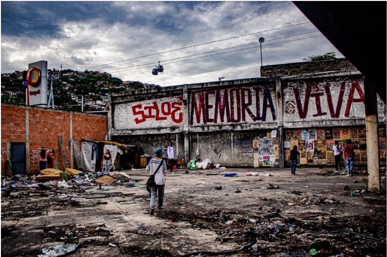
Dollarcity desde el interior, se puede ver aún restos de lo que dejó el incendio
