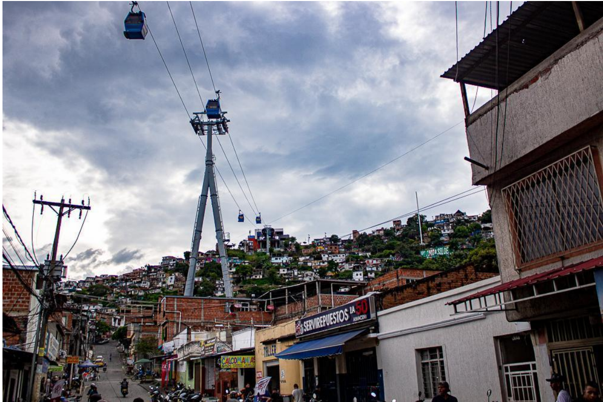
Infraestructura del mío Cable vista desde la parte baja de Siloé
