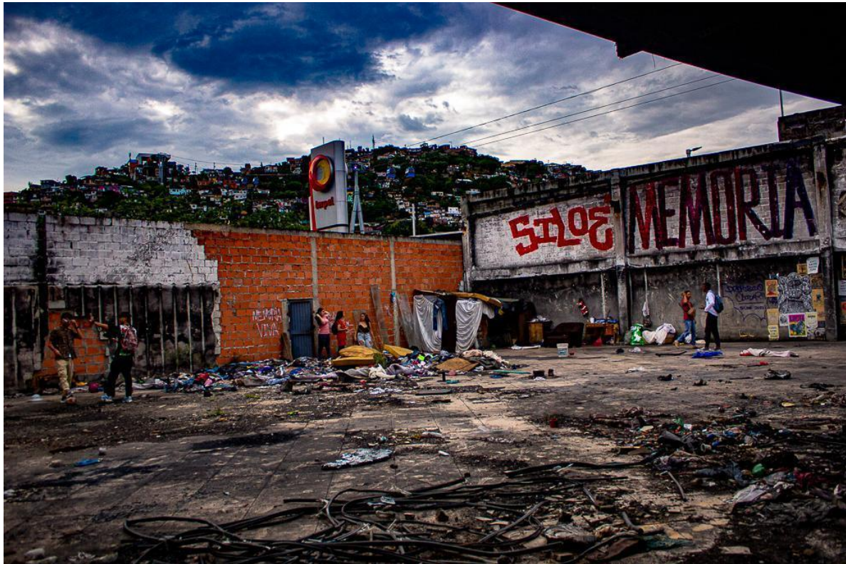
Se pueden ver cables, basura y las paredes quemadas, a lo lejos la comuna 20 y la gasolinera Terpel
