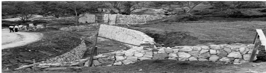
(imagen 2. fuente: Zoológico de Cali. Construcción de los muros de contención de las exhibiciones. Foto sin fecha)
