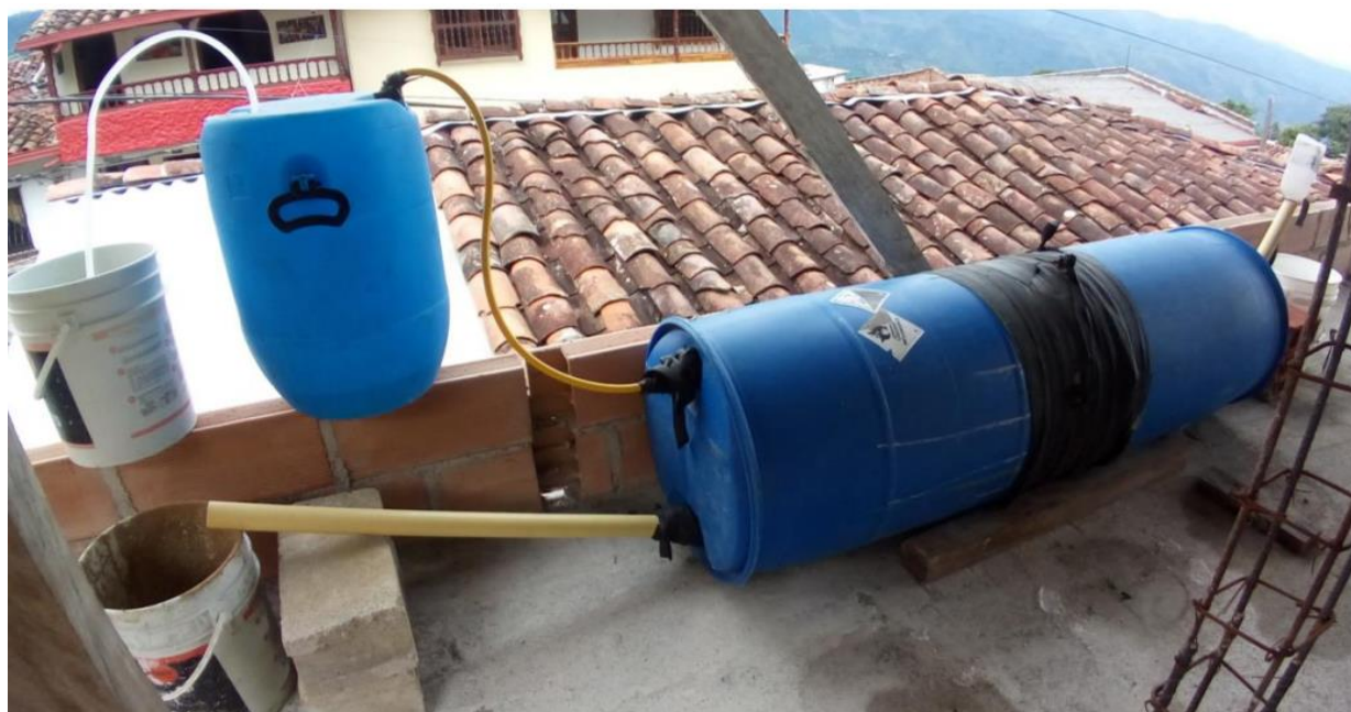
Figura 41. Tomado. Biodigestor de 400 L para producción de biogás con pulpa de café como sustrato. (Londoño, 2017)
