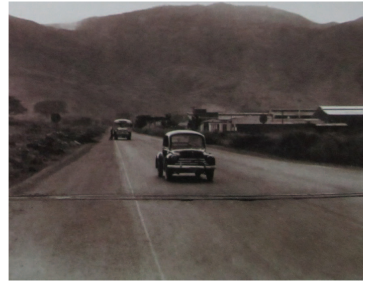
Imagen 14. Pavimentación de la vía principal del municipio que conecta con la ciudad de Cali; además se aprecia en pleno desarrollo la Urbanización Acopi.
