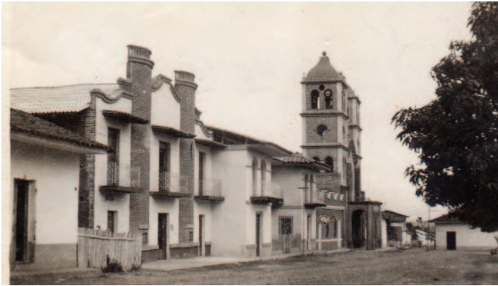
Una de las obras realizadas por el Cura Fray Peña, la edificación estaba conformada así: el ala izquierda Teatro Belalcázar, el ala central Casa Cural, y ala derecha el Templo Parroquial.
