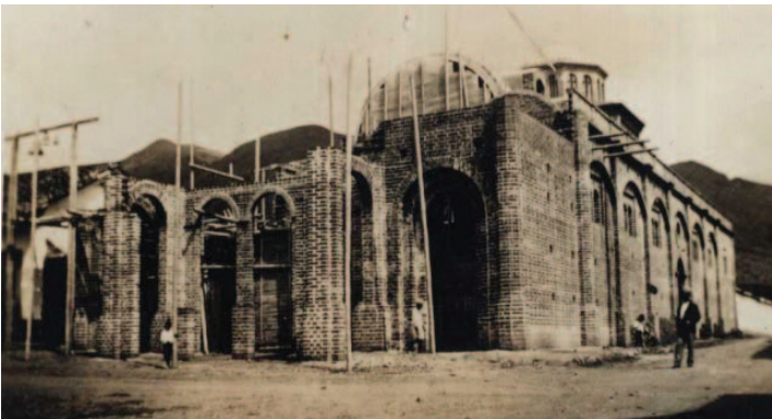
Imagen 48. Construcción de la Iglesia del Parque Belalcázar Fotografía tomada del libro Monografías de Yumbo
