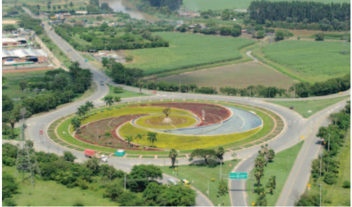
Imagen 42. Glorieta de Cencar en el centro Monumento a la Industria - Fotografía tomada por el CAMY
