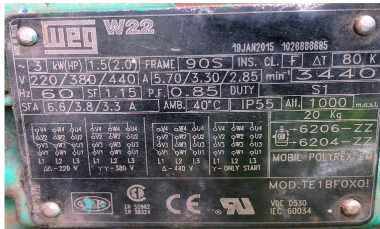
Figura 74. Placa característica bomba de muestreo 2 agua cruda bocatoma.
