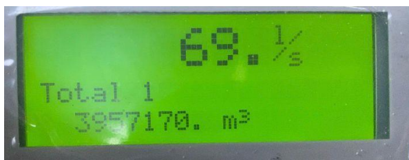
Figura 31. Caudal de salida de la bomba # 2 de la estación de bombeo Bellavista #3 de la planta Rio Cali (Elaboración propia).
