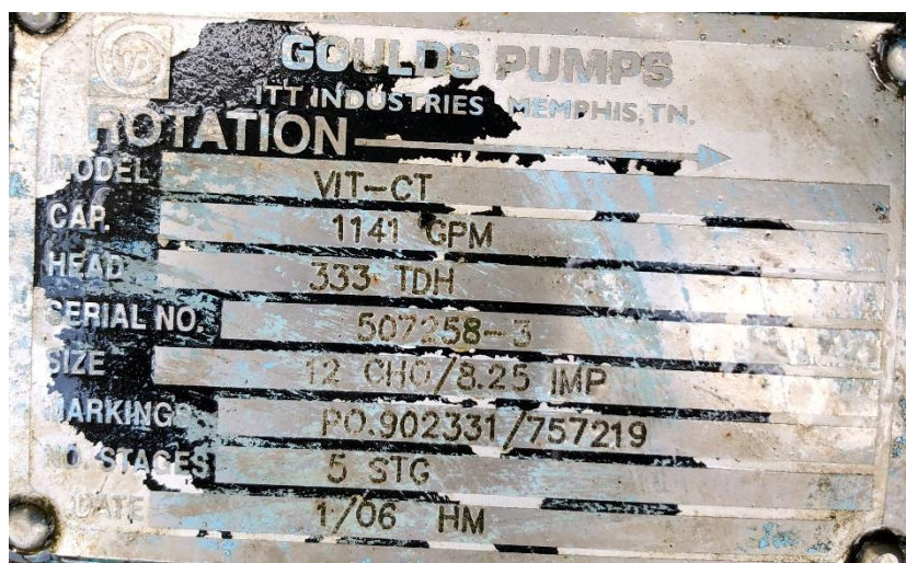
Figura 109. Placa Característica bomba #4 Bellavista 3.
