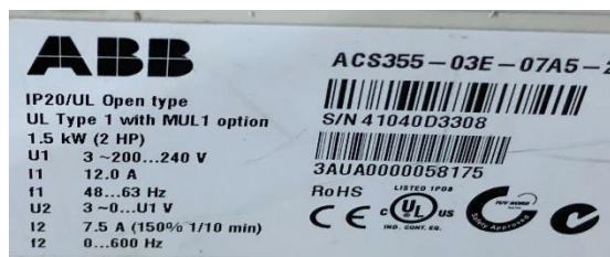
Figura 83. Placa motor y Variador, dosificación de coagulante # 2.
