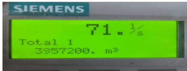
Figura 39. Caudal de salida de la bomba # 3 de la estación de bombeo Bellavista #3 de la planta Rio Cali (Elaboración propia).
