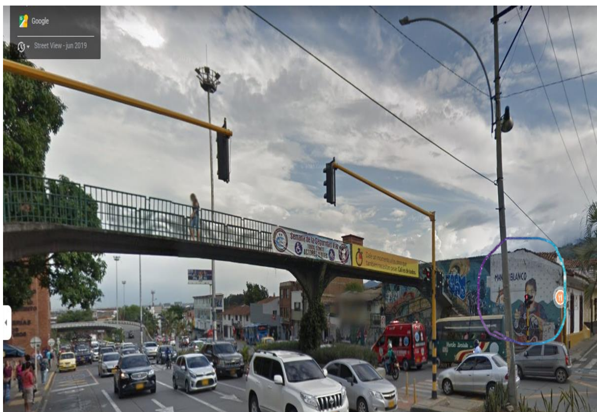
Figura 11. Manjarblanco la delicia del valle, puente de la calle 5ta a la altura del edificio Comfenalco
