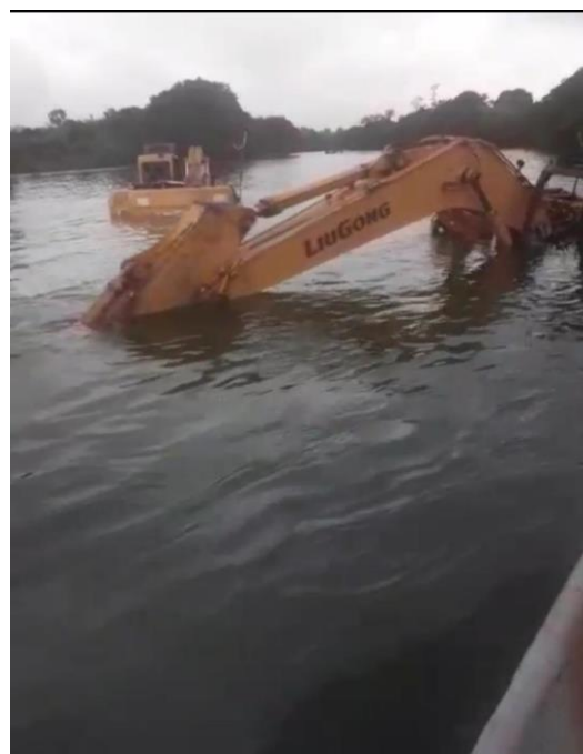
Ilustración 12 Destrucción de retroexcavadoras
