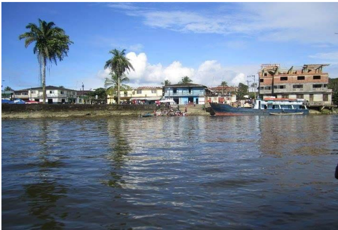
ANEXO 1: Cabecera y muelle central de Santa Bárbara de Timbiquí. Foto tomada por Yina Patricia Torres, habitante local. Julio de 2014.
