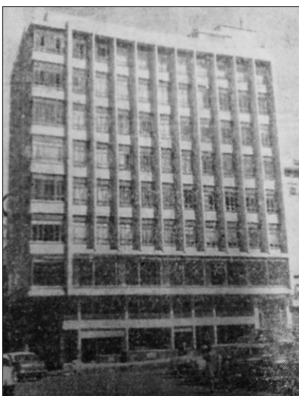
Figura 27. Edificio de Cementos del Valle S.A., en la carrera 5ª N° 11-68 en la plaza de Caicedo, recién inaugurado en 1955. El País. (1955, 17 de octubre). Año VI, núm. 1972, p.2.
