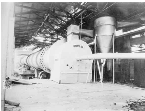
Figura 17. Horno N° 1 de Cementos del Valle S.A. (1941). Puerto Isaacs & 200038.
