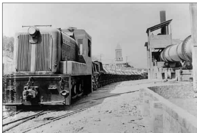
Figura 14. Vehículo de transporte de materia prima por vía férrea, en la Planta de Cementos del Valle S.A. en Puerto Isaacs. Fuente: (1941). Planta de producción, vehículo de transporte, 1941 & 200132. OTRO: Biblioteca Departamental Jorge Garcés Borrero.
