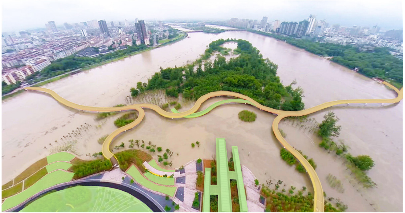
Ejemplo de espacios que responden a la actividad y espacios que responden a la función. Yanweizhou park en jinhua marea alta.
