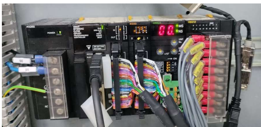
Figura 8. PLC OMRON CJ1M CPU21 con carta DeviceNET, Entradas Digitales y Salidas Digitales. Fuente: Elaboración propia, 2025
