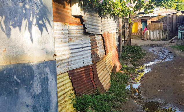
Muros ciego - quebrada.
