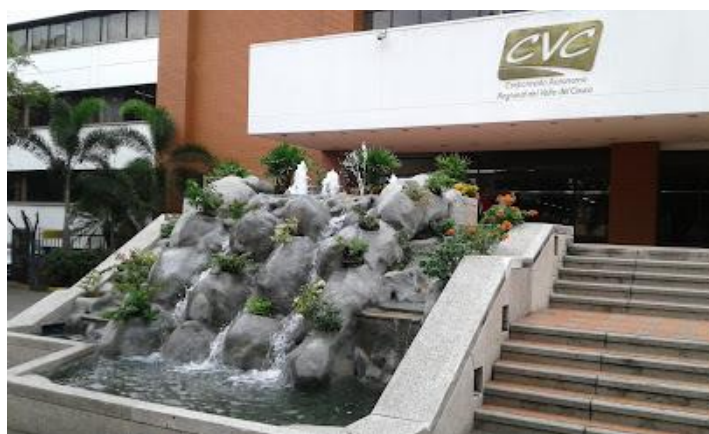
Fotografía 3. Parte exterior de la sede administrativa de la CVC.
