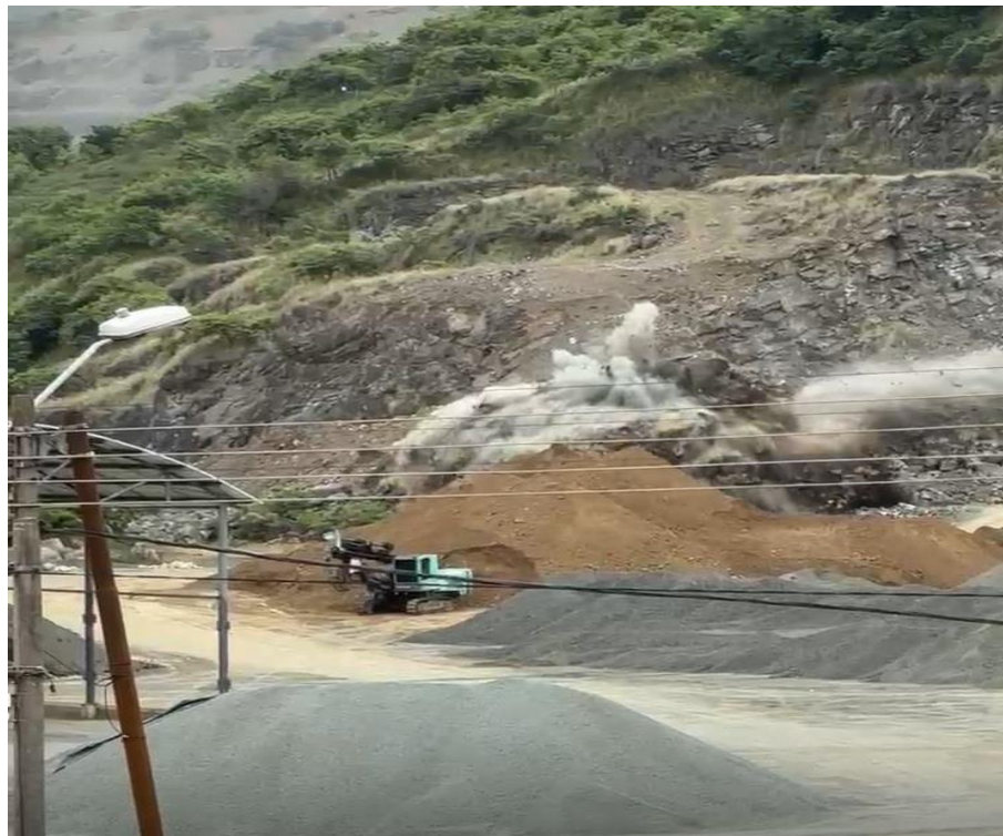
Fotografía 6. Detonación voladura 13/05/25, empresa Perea S.A.S, cantera Arroyo hondo.
