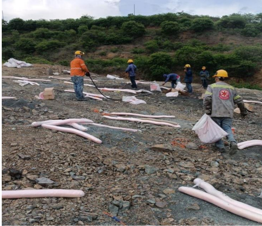
Fotografía 3. Preparación del explosivo para la voladura 09/04/25, empresa Agregados La Roca., cantera Guabinas.
