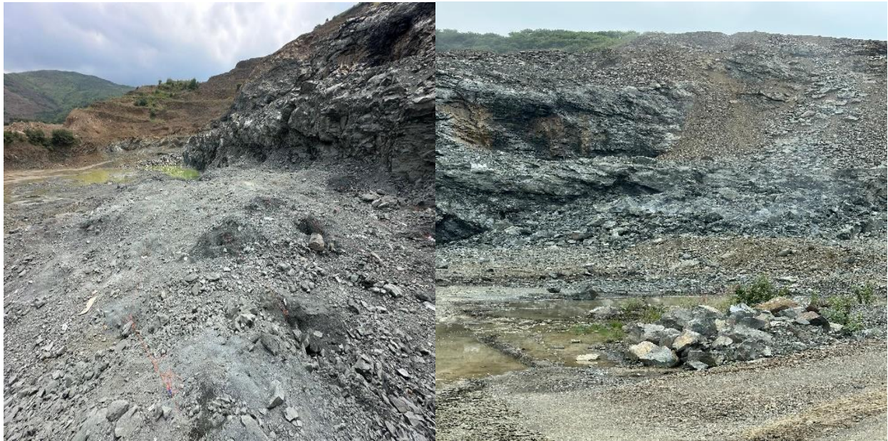
Figura 23-Antes y después voladura (Fecha registro 24-05-2025). Fuente: Los autores
