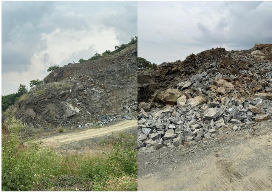
Figura 21-Antes y después voladura (fecha registro 13-05-2025). Fuente: Los autores
