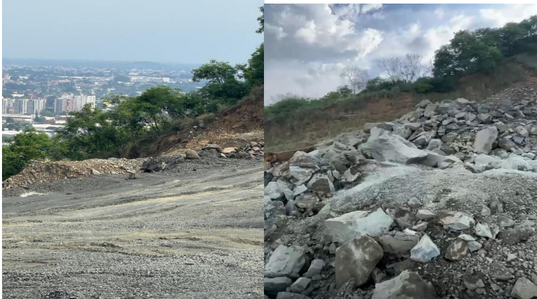
Figura 19- Antes y después voladura (Fecha registro 20-03-2025) Fuente: Los autores
