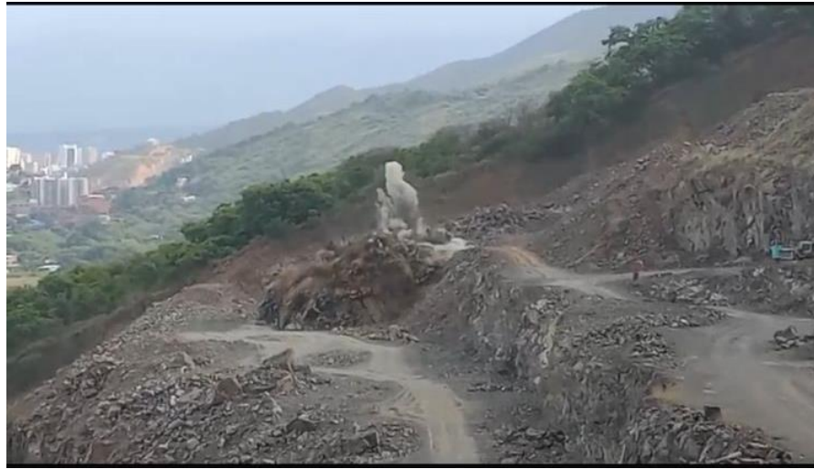
Fotografía 1. Voladura 20/03/25, empresa Perea S.A.S, cantera Arroyo hondo.
