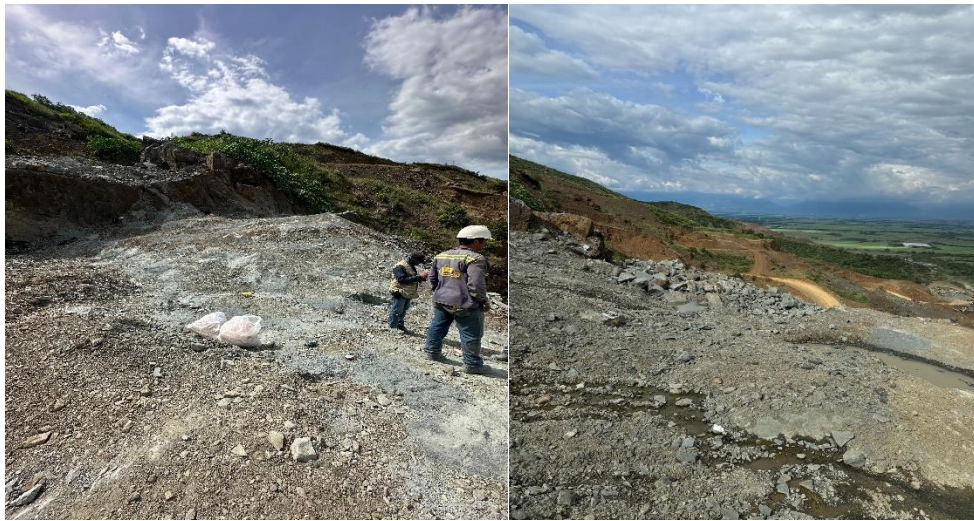
Figura 25-Antes y después voladura (Fecha registro 29-05-2025).Fuente: Los autores
