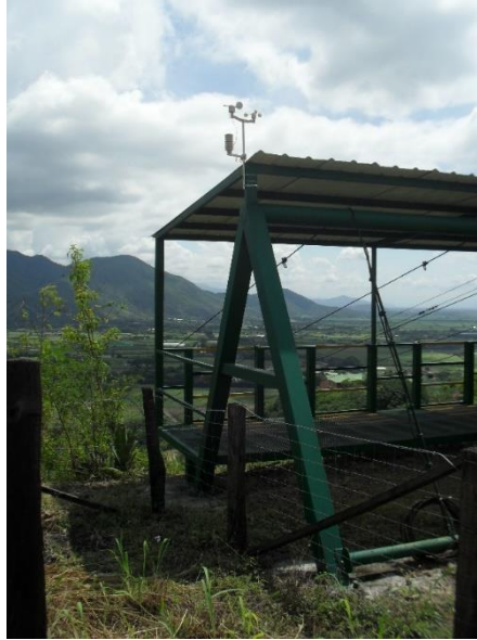
Figura 4. Instalación del anemómetro
