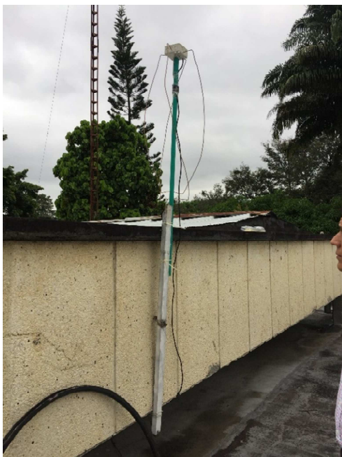
Figura 12. Instalación de la antena.
