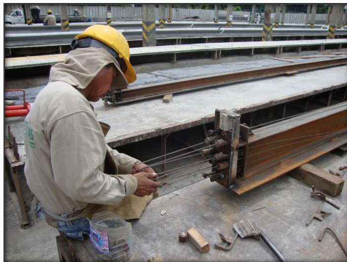
Foto 2. Ensamble del suck y cuñas para tensado de viga IPE 200
