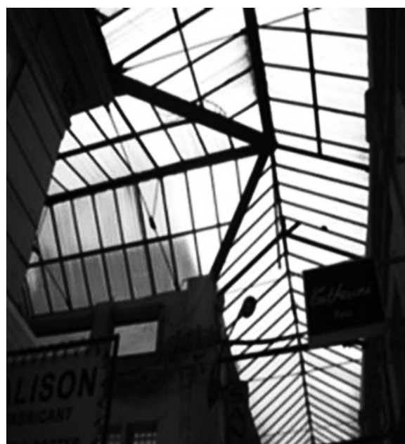
45. Passage du Caire . Techos acristalados.
