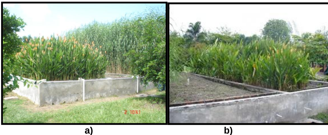
Figura 12. Humedal Subsuperficial en la Planta de Tratamiento de Aguas Residuales ACUAVALLE. a) Afluente del humedal subsuperficial de Heliconia psittacorum . b) Efluente del humedal subsuperficial de Heliconia psittacorum .
