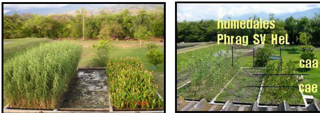
Figura 10. Vista de los Humedales Subsuperficiales: a) Vista general. b) Phrag: Humedal plantado con Phragmites australis ; SV: humedal sin vegetación; Caa: columna de agua afluyente; Cae: columna de agua efluente; Hel: humedal plantado con Heliconia psittacorum (Fuente: Trinidad 2006).
